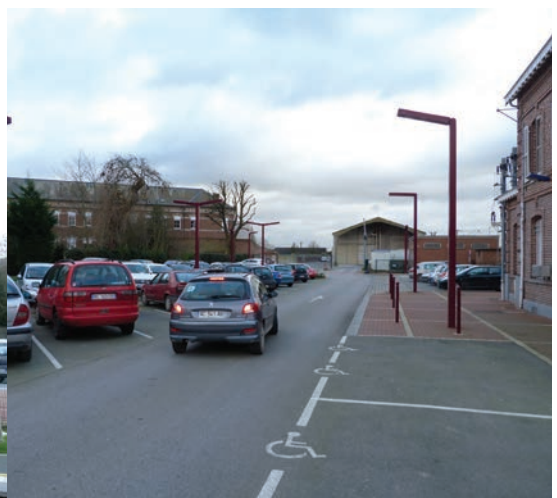
Vues côté quais et côté parvis - Arnèke
