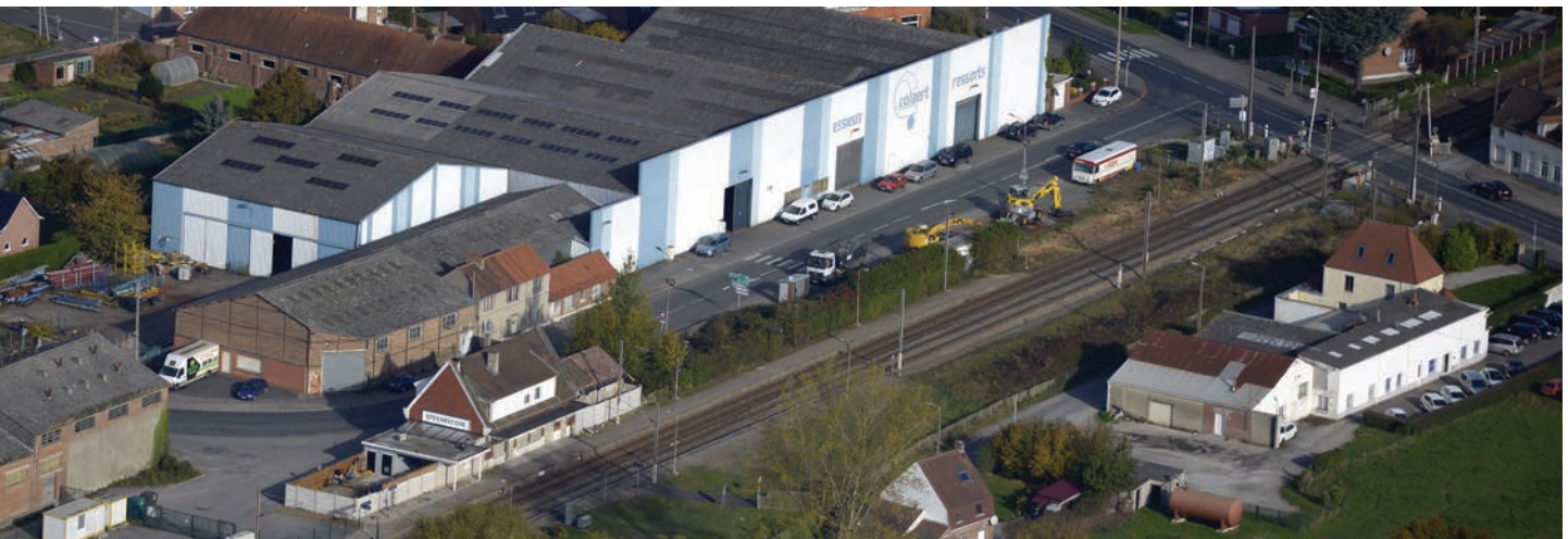
Vue aérienne sur la gare - Steenbecque
