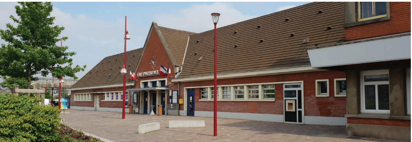
Vue sur la gare côté parvis - Hazebrouck
