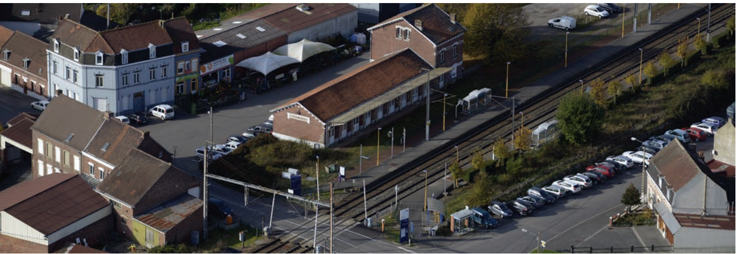
Vue aérienne sur la gare - Steenwerck
