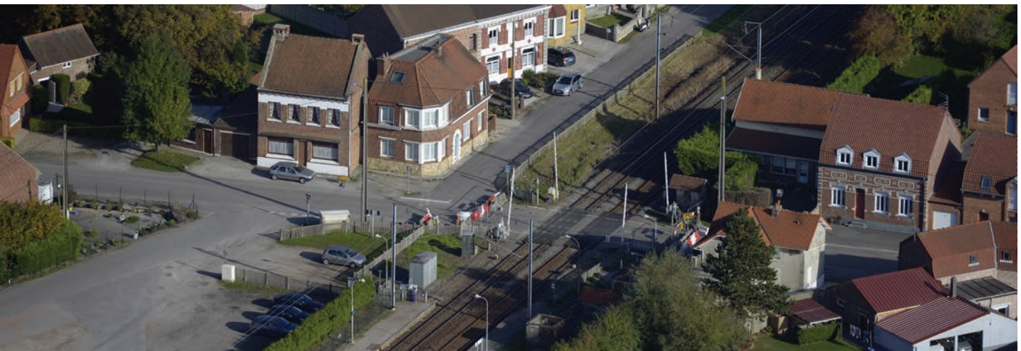
Vue aérienne sur les quais et le parking de la halte - Renescure
